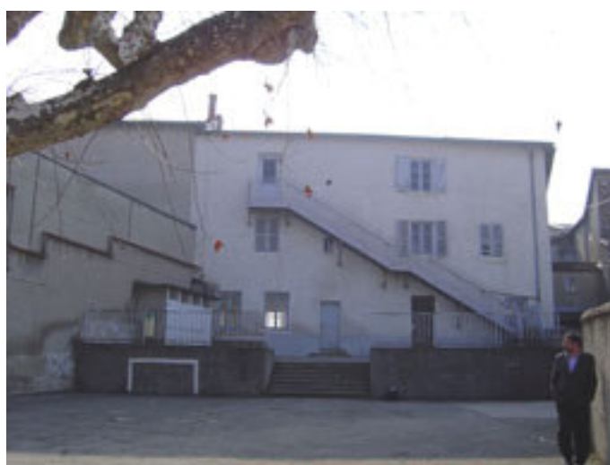
Vue sur la façade intérieure du bâtiment
