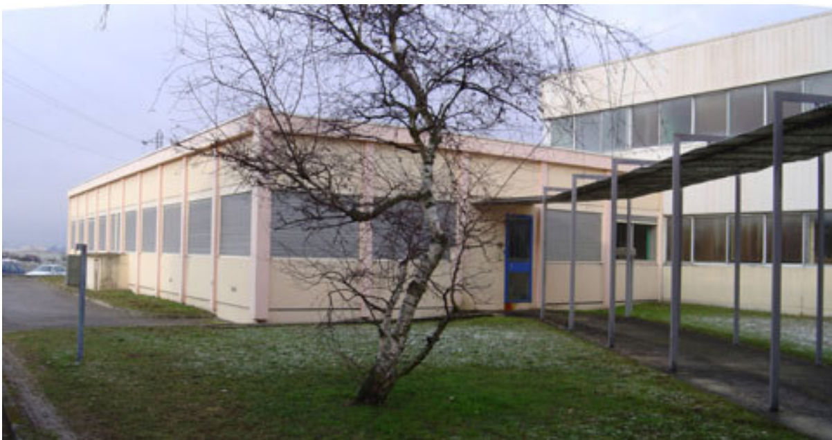
Vue depuis le jardin sur la seconde entrée du bâtiment
